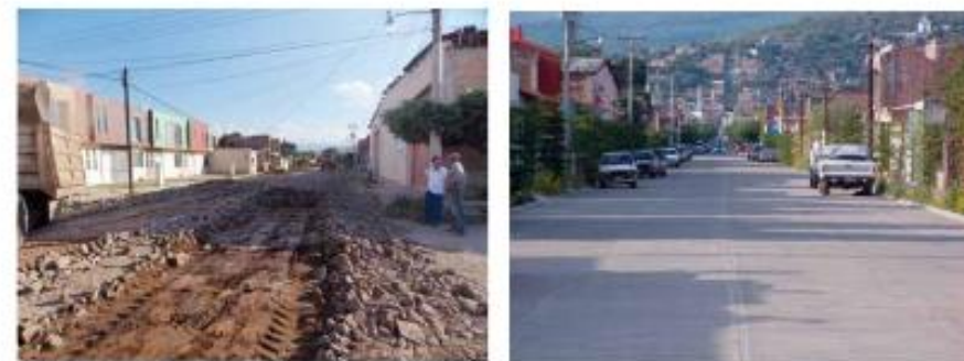
Pavimentación de la calle Morelos entre Circunvalación y Laura Cosío
