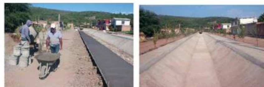
Entubamiento del dren Juan Carbajal
