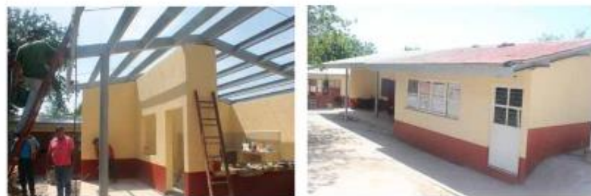
Construcción de cocina-denzanador y bodega en la escuela Manuel Crespo Menéndez en El Cacalote
