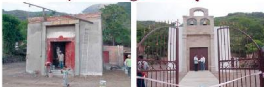
Rehabilitación del Templo en la comunidad de La Laja
