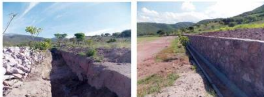
Rehabilitación de muro perimetral de la Unidad Deportiva Pasen del Centenario
