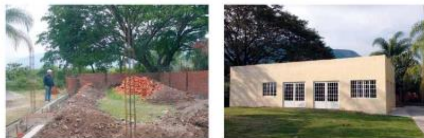
Construcción de Casa Comunitaria en la Puerta de Barro
