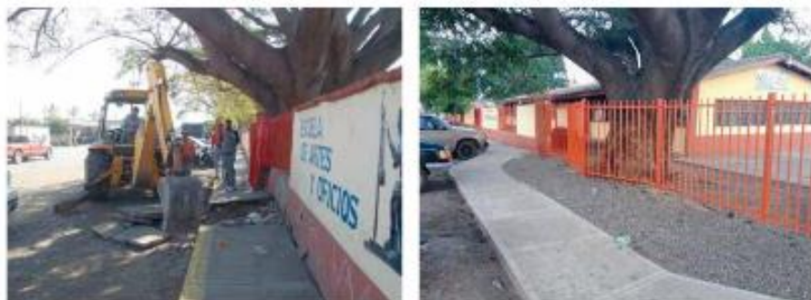
Rehabilitación de banqueta y barandal en la escuela Nilo Artillero
