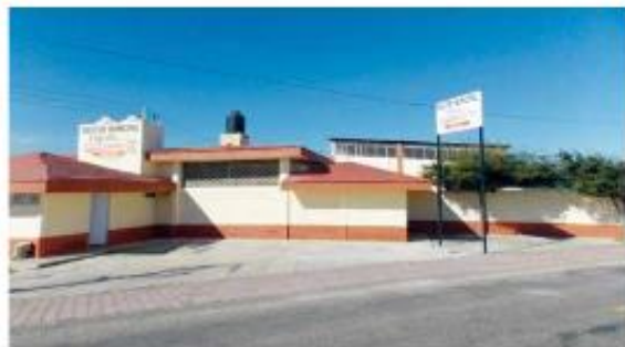
Instalaciones del Rastro Municipal
