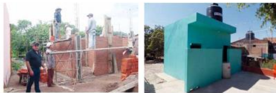
Construcción de baños en el Jardín de El Palo Blanco
