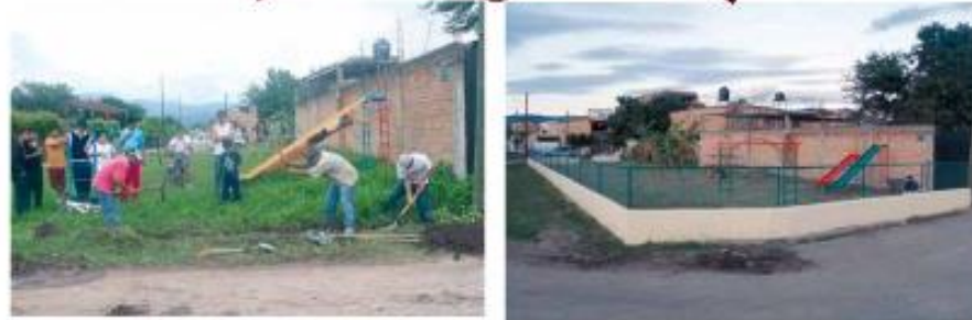
Pintura de los puentes y circulado del parque en la colonia Las Flores
