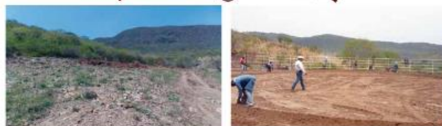
Construcción de corral para manejo de ganado en Las Pilas
