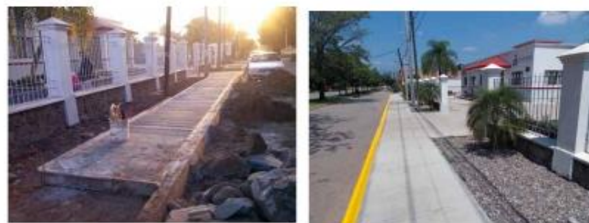
Construcción de banqueta y decoración con palmas afuera del Hospital de Primer Contacto
