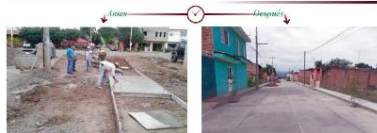
Pavimentación con concreto hidráulico de la calle Prolongación Corregidora entre las calles Circunvalación y Laura Cosío
