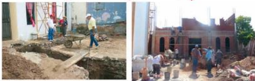
Ampliación de Presidencia Municipal, primera etapa
