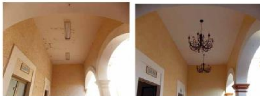
Pintura y colocación de candiles en la Presidencia antigua
