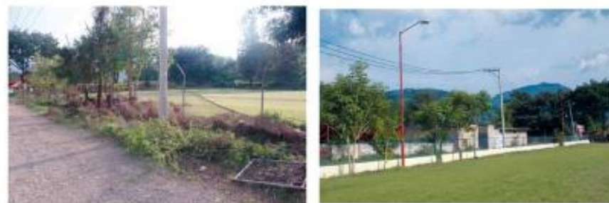
Cercado de la cancha de fútbol, construcción de baños y alumbrado en El Aguacate
