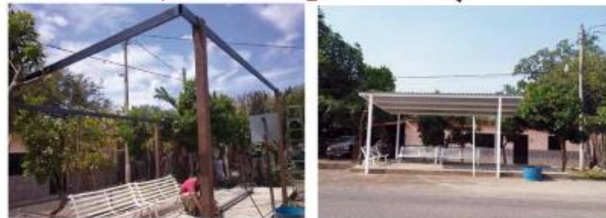
Rehabilitación de la parada de autobús en Ayaguala
