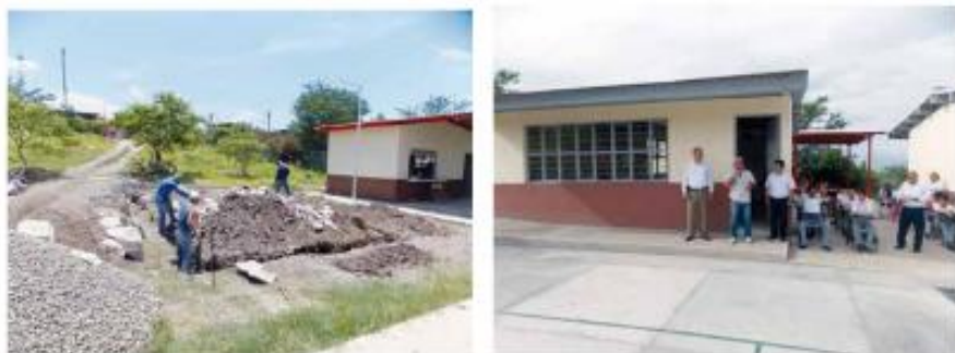
Construcción de aula distancia en la telesecundaria Rafael Preciado Hernández
